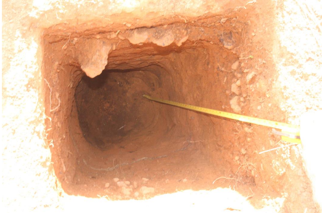
Processo de decapagem, com um metro de profundidade. Fonte: Arquivo Pessoal - Bairro do Gato Preto, Cajamar.
