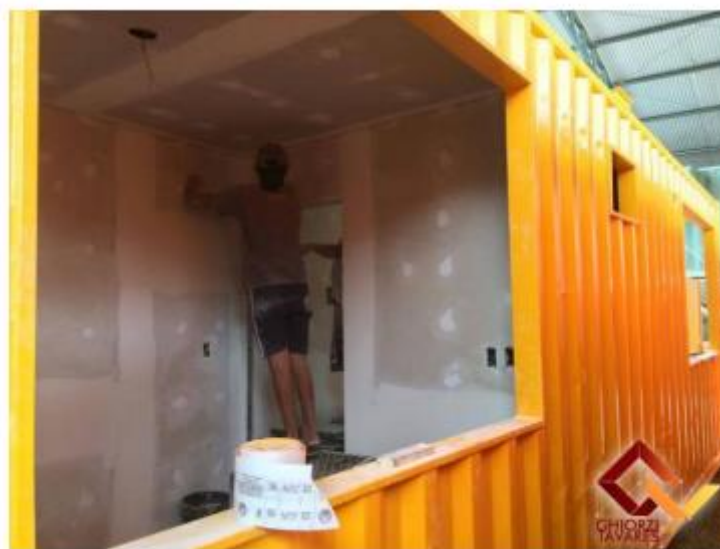
Figura 13 - Compartimentação com gesso acartonado
