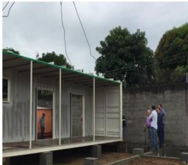
Figura 12 – Pilaretes de concreto para apoio de contêiner
