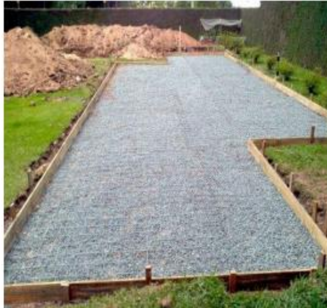
Figura 11 - Radier armado
