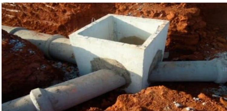
**Figura 3 - Caixa de inspeção de concreto**
