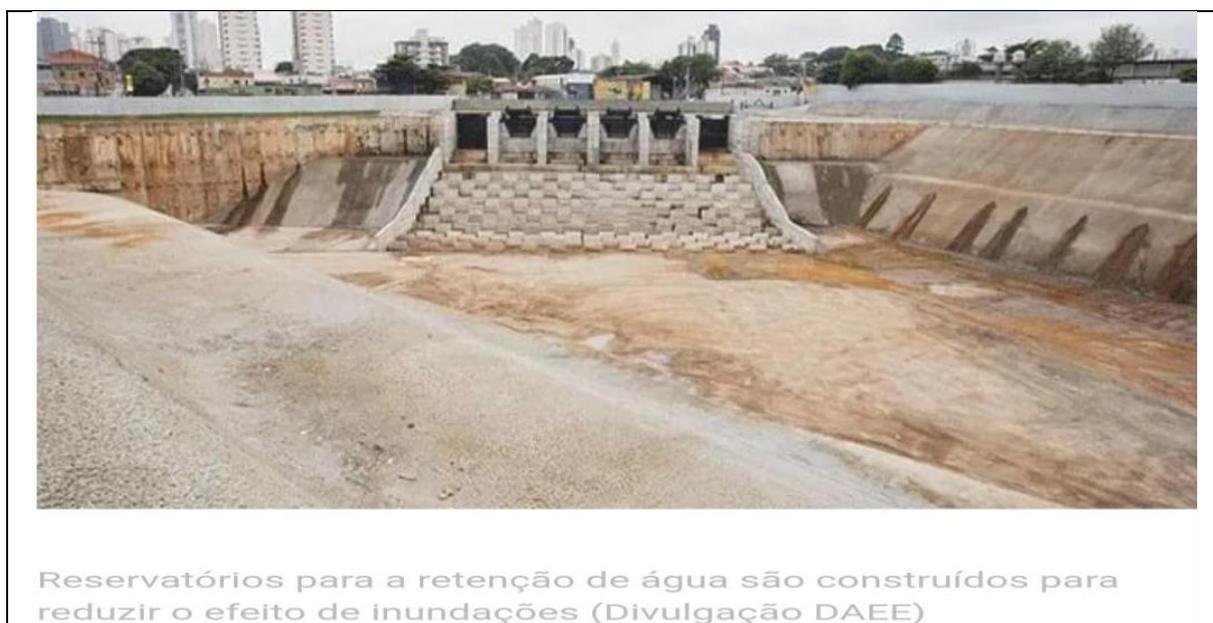
**Figura 6 – Reservatório para retenção de água**
