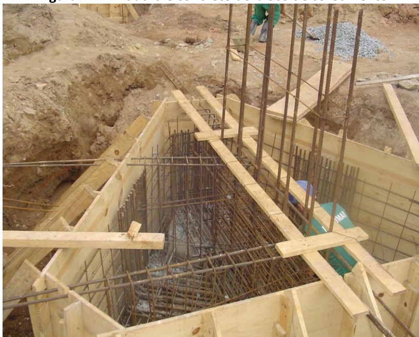
Figura 4– Armadura e concreto do bloco de coroamento
