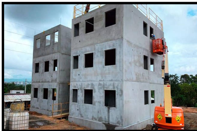
Figura 5 – Paredes de concreto moldadas in loco.
