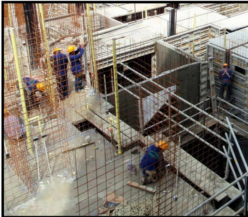
Figura 11 –Armadura da parede de concreto.
