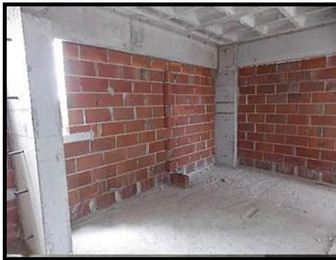
Figura 1 – Alvenaria de Vedação com Blocos Cerâmicos Fonte: ( http://www.politech.poli.br ) acessado em 04/05/2023.
