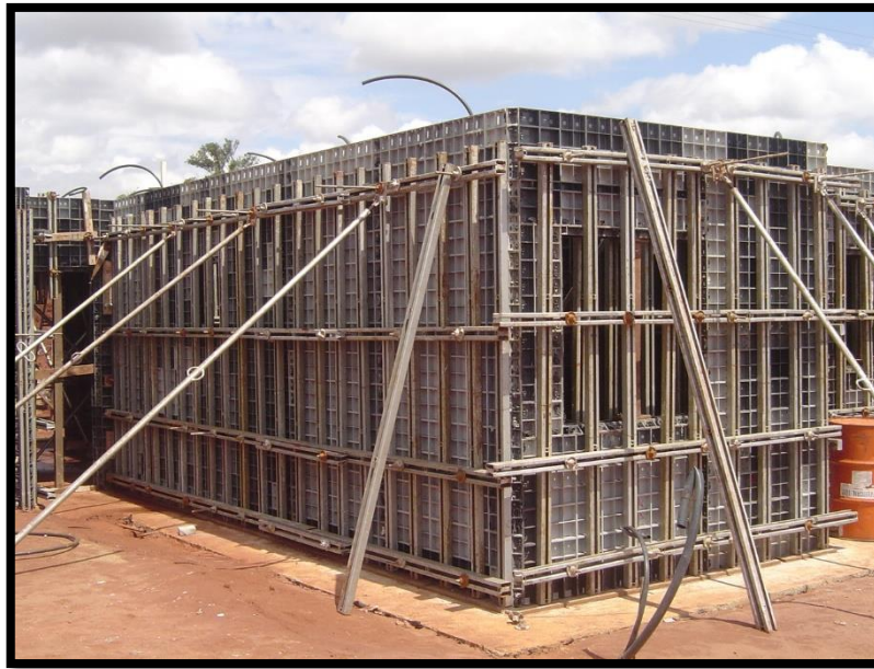
Figura 9 –Formas de alumínio montadas e escoradas.
