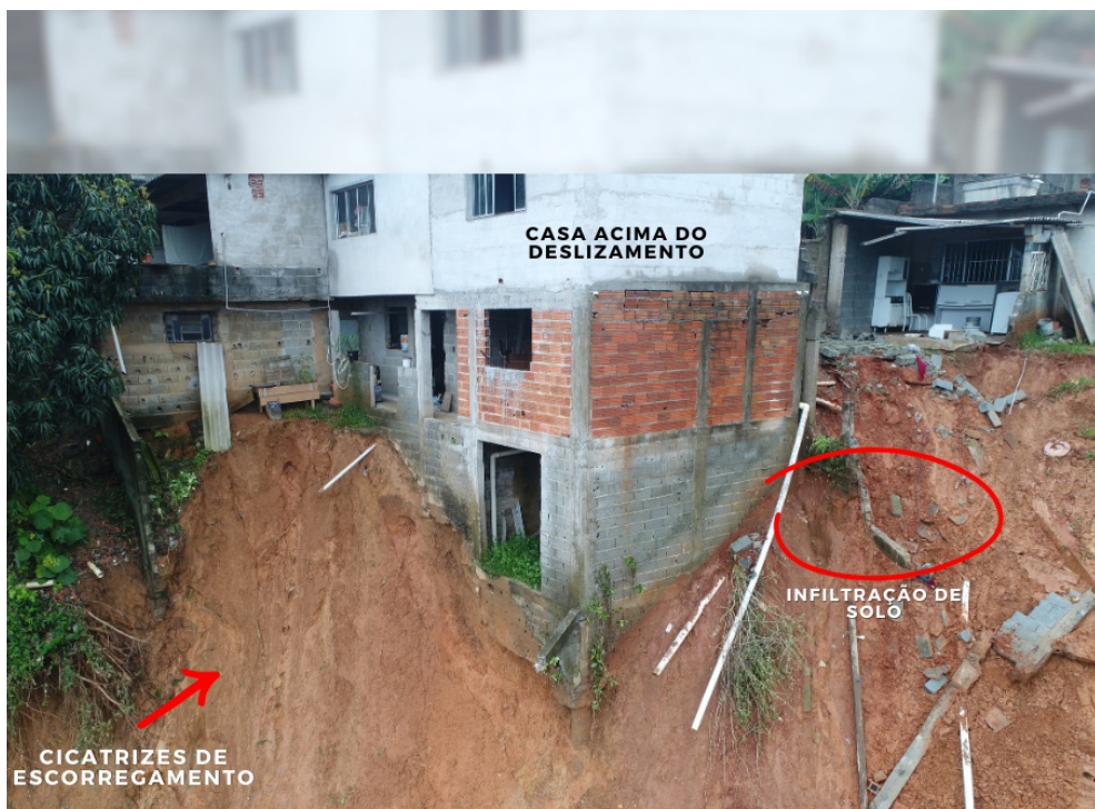
Apresentação de um terreno após o deslizamento do talude ir abaixo (por: Khananda Beatriz)
