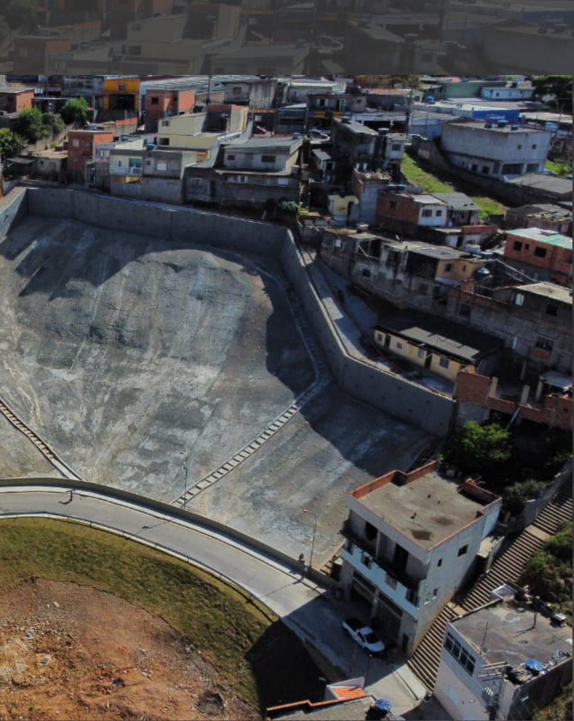
Primeiro muro de contenção da Rua São Carlos (foto: Prefeitura Municipal de Franco da Rocha/ Orlando Junior)
