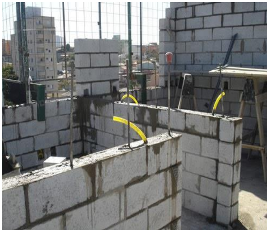
Figura 4 – Instalações Elétricas em alvenaria estrutural
