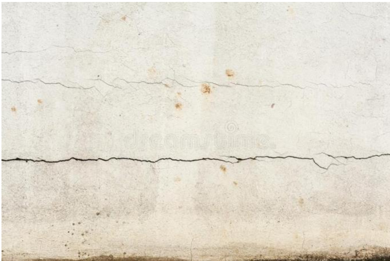
Figura 19 – Fissura Horizontal
