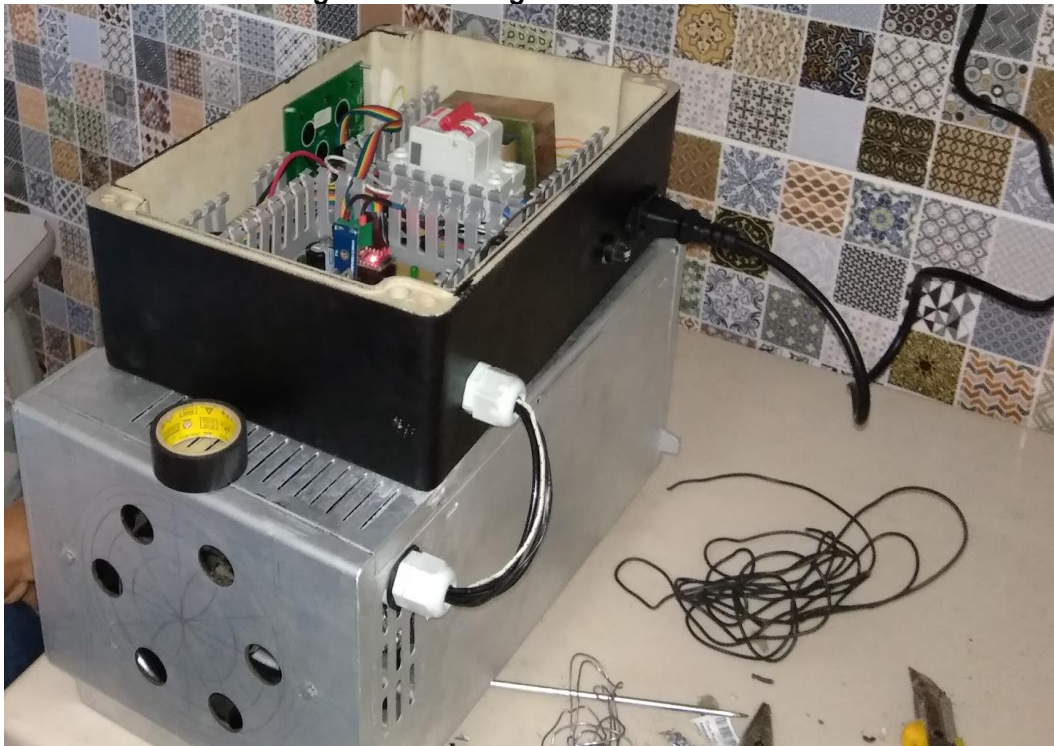
Figura 43 - Passagem de cabeamento.
