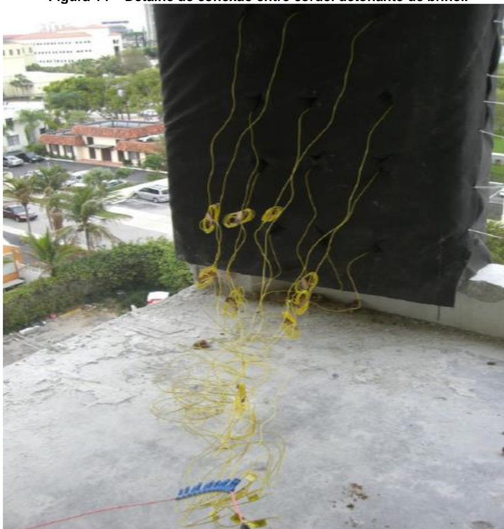
Figura 14 – Detalhe de conexão entre cordel detonante de brinel.
