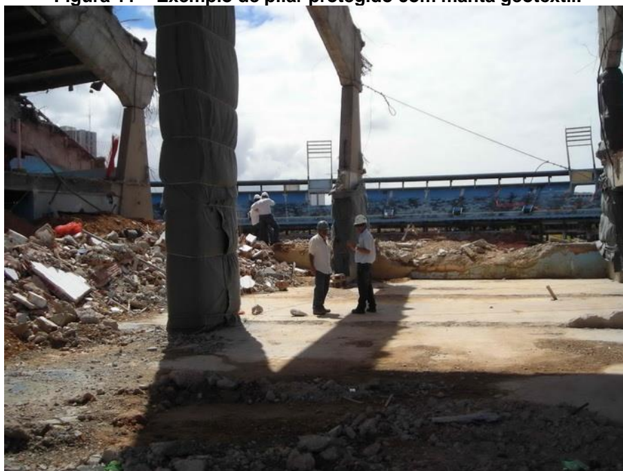
Figura 11 – Exemplo de pilar protegido com manta geotêxtil.
