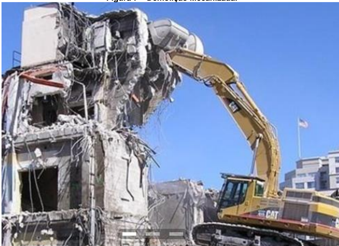
Figura 7 – Demolição Mecanizada.
