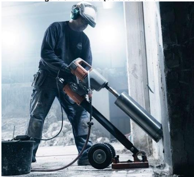
Figura 8 – Perfuração das colunas
