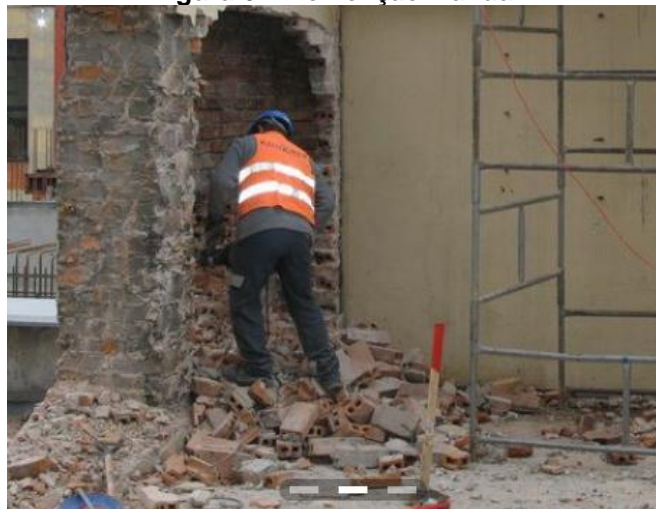
Figura 6 – Demolição Manual
