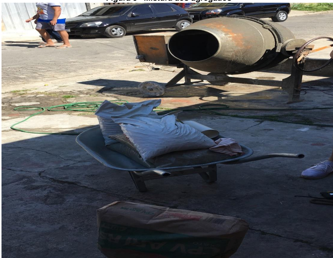
Figura 5 –Mistura dos agregados
