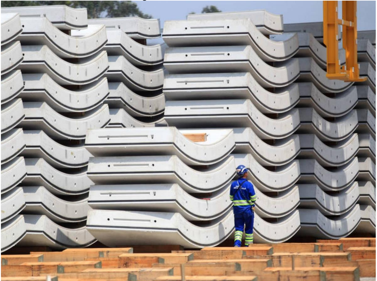
Figura 19 - Obras do Metrô
