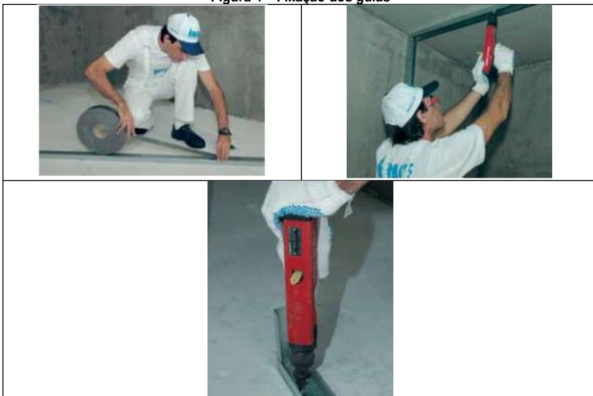
Figura 4 – Fixação dos guias
