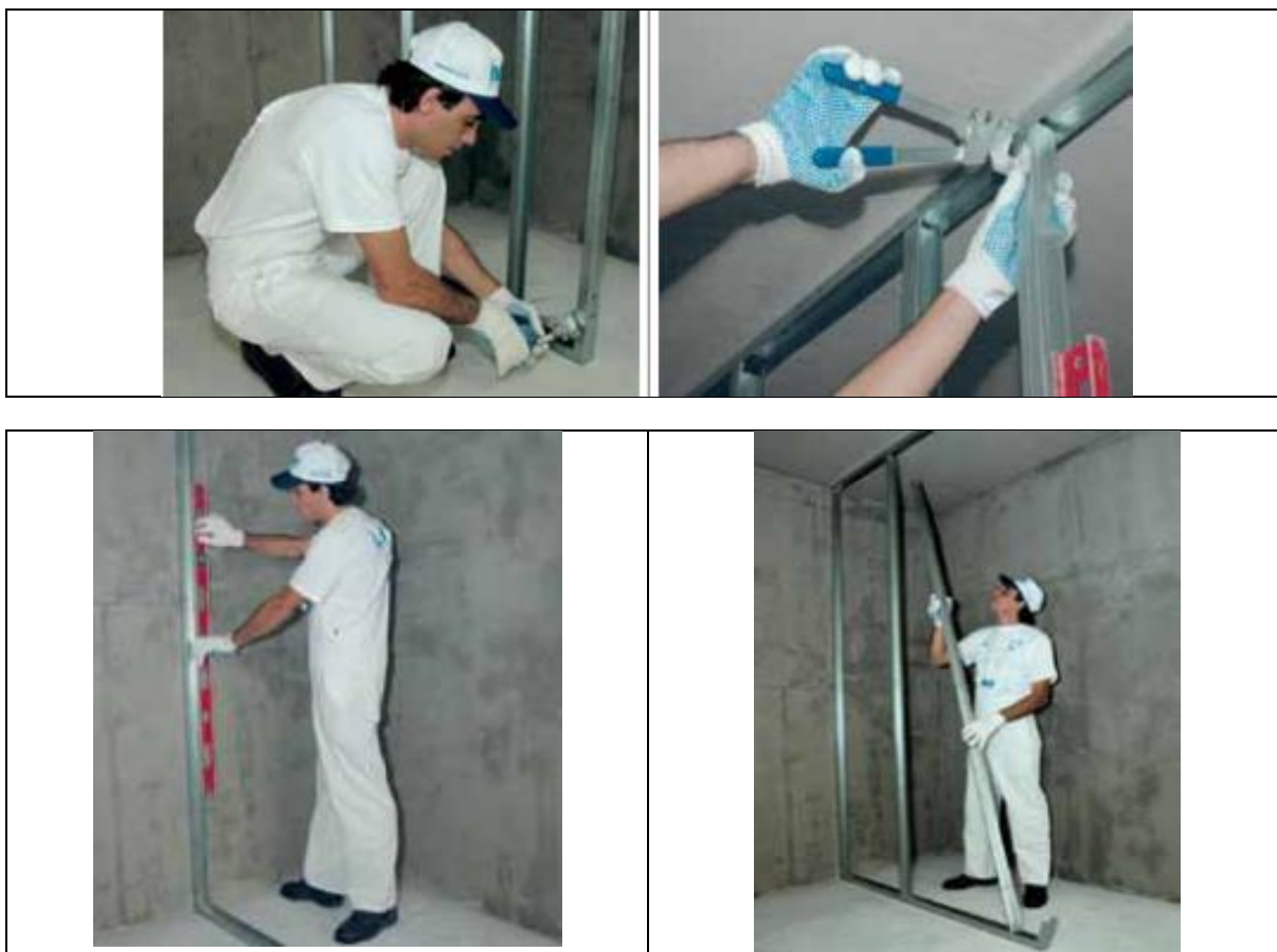
FIGURA 5 – INSTALAÇÃO DOS MONTANTES
