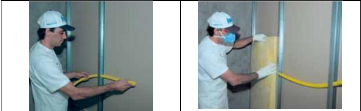
Figura 8 – Instalações elétricas; hidráulicas e colocação da lã.
