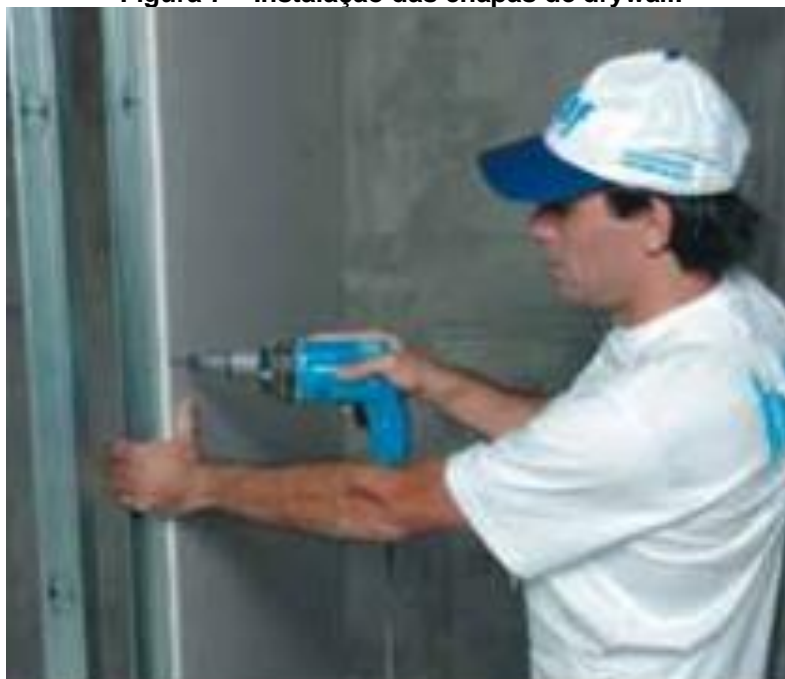
Figura 7 – Instalação das chapas de drywall.
