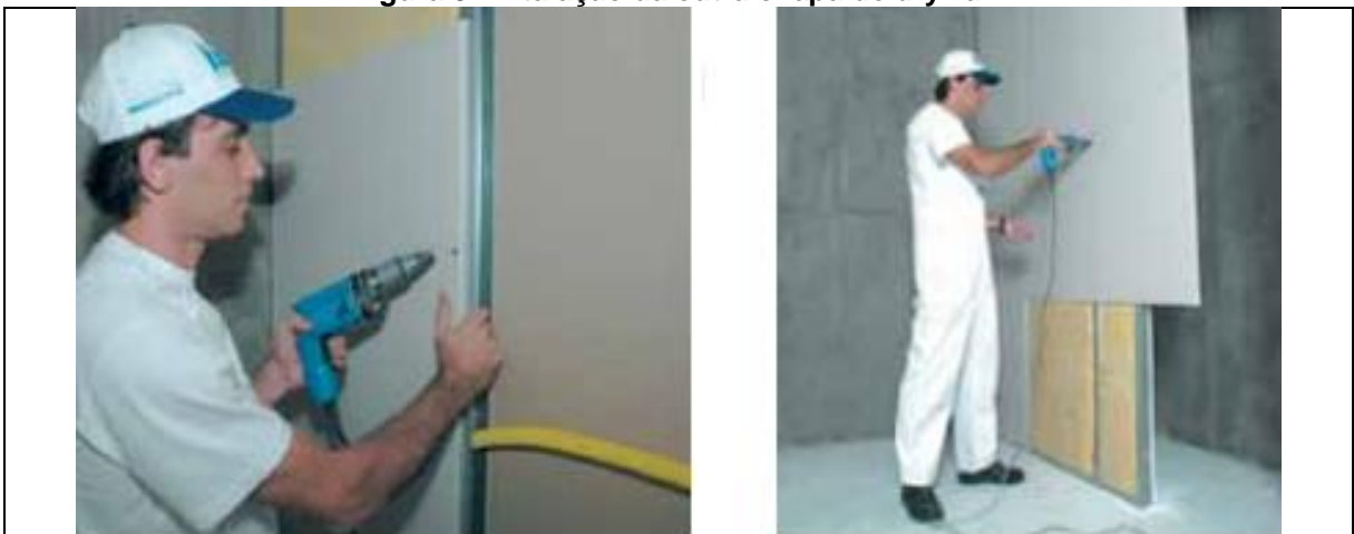
Figura 9 - Instalação da outra chapa de drywall.
