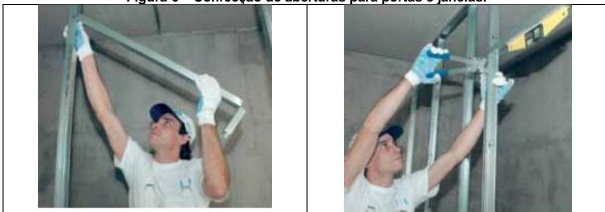
Figura 6 – Confecção de aberturas para portas e janelas.
