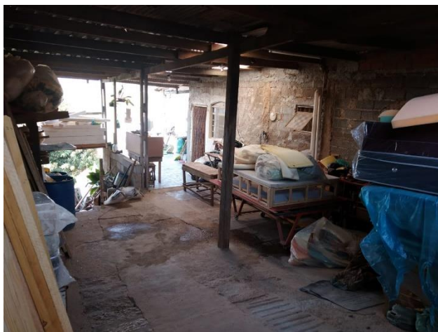
Figura 11 - Cenário antes da implantação – Galpão
