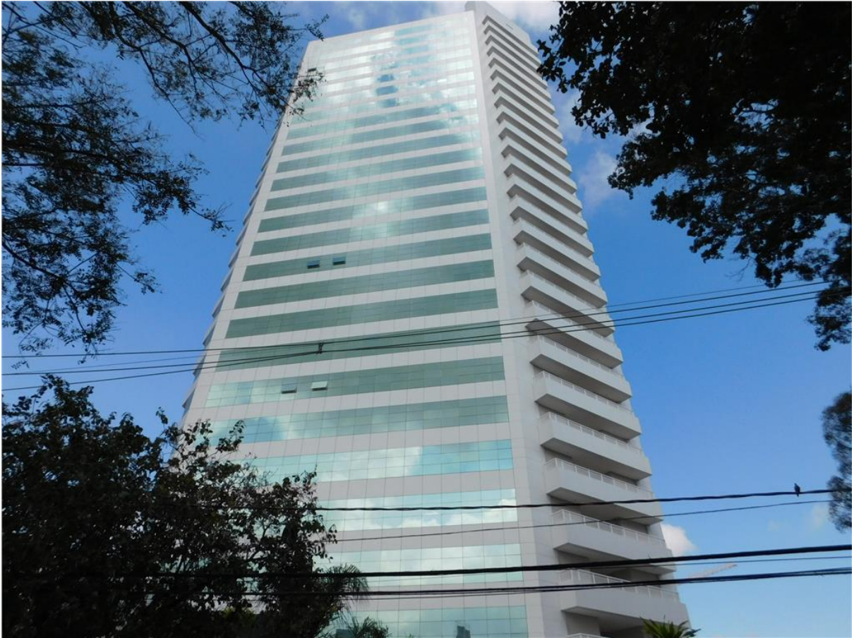
Figura 8 - Edifício Golden Office na cidade de Jundiaí, São Paulo
