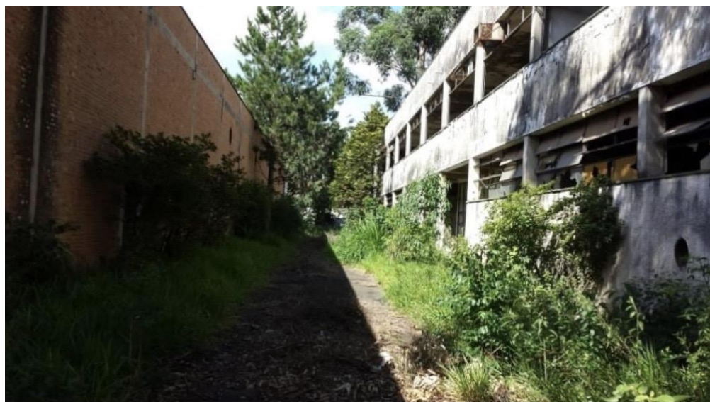
Figura 16 - Estrutura antiga do shopping
