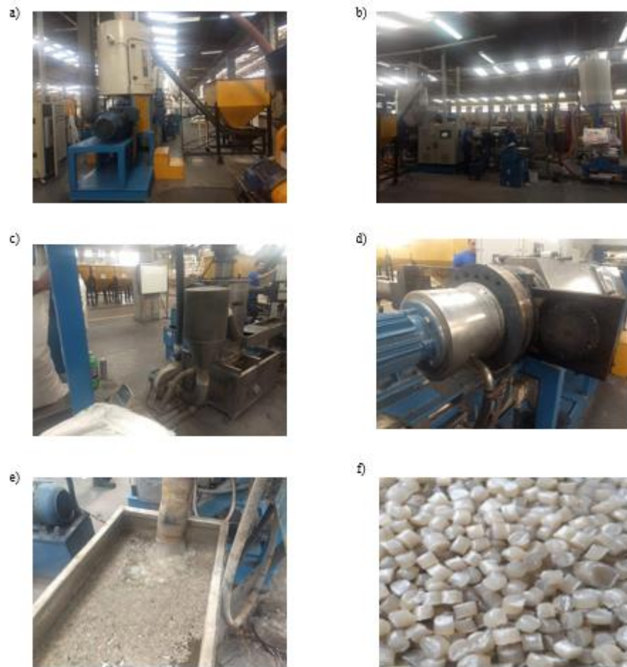
Figura 23: Área de extrusão: a), b) e c) Extrusão, d) cabeçote da extrusora, e) saída grãos plásticos, f) pallets.
