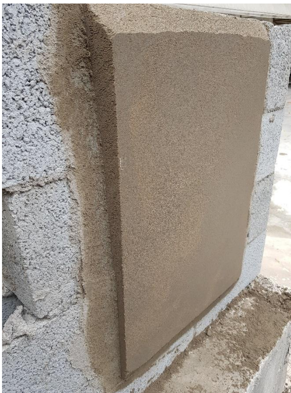
Figura 28 – Visão lateral da aplicação argamassa convencional na parede
