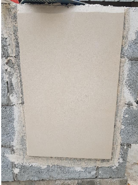
Figura 30 - Aplicação argamassa modificada na parede
