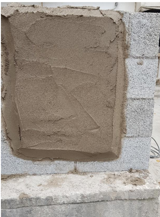
Figura 26 - Aplicação argamassa convencional na parede
