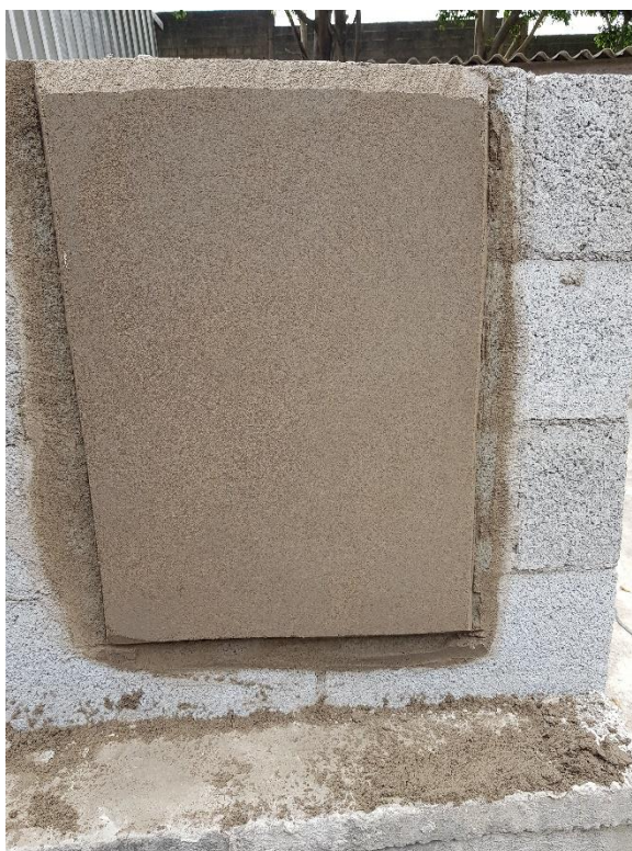
Figura 27 - Aplicação argamassa convencional na parede
