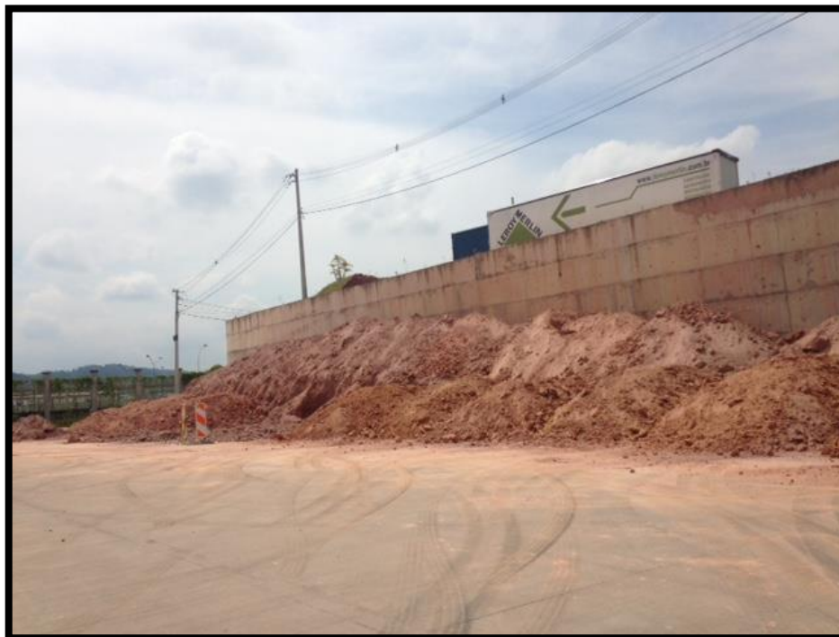
Muro em fase inicial do projeto está sendo “escorado” com terra para posterior contenção.
