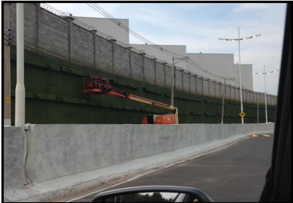
Contenção do muro em processo de finalização através de projeto com utilização de tirantes.
