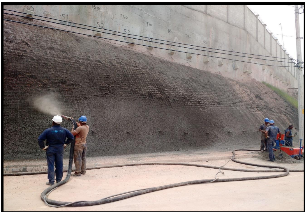
Concretagem de um local que foi feita a contenção através de “solo grampeado”
