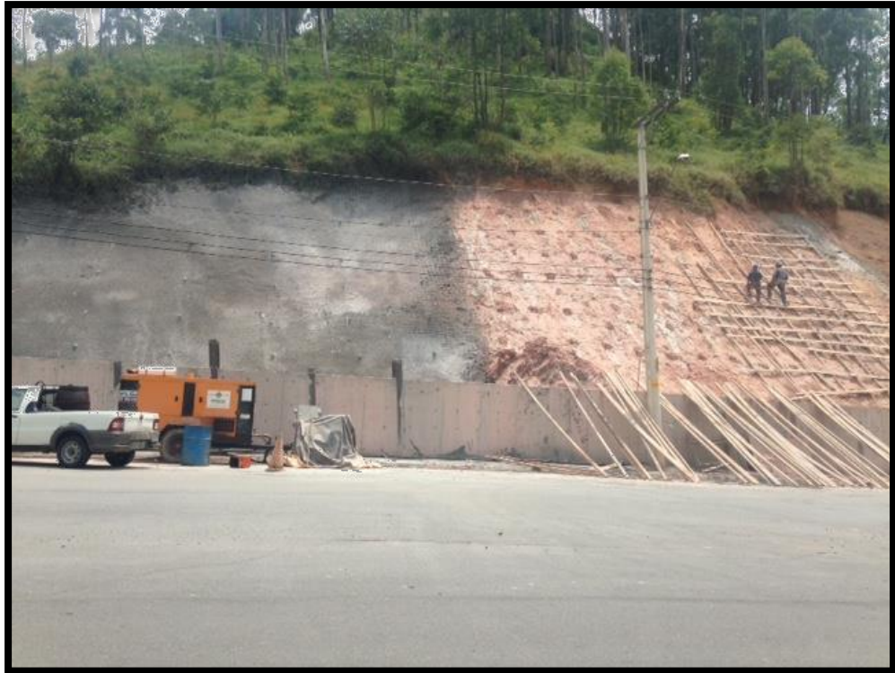
Projeto de solo grampeado, à esquerda o talude já foi concretado, já à direita os grampos estão sendo colocados, para posteriormente incluir a malha de ferro e concretar.
