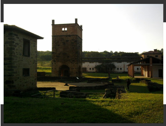
Alto Forno de Mursa: Construção do século XIX pertencente à planta da Fábrica considerada primeira da Siderurgia Nacional
